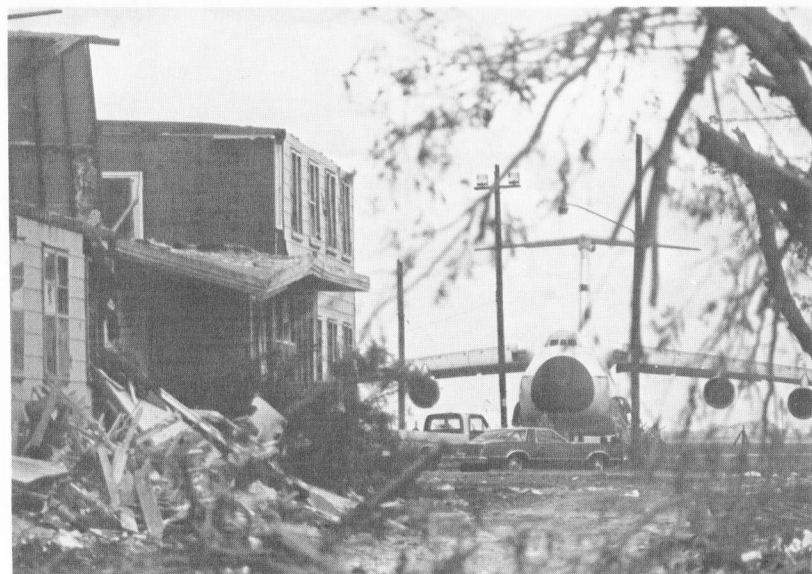
Aftermath of a tornado.
